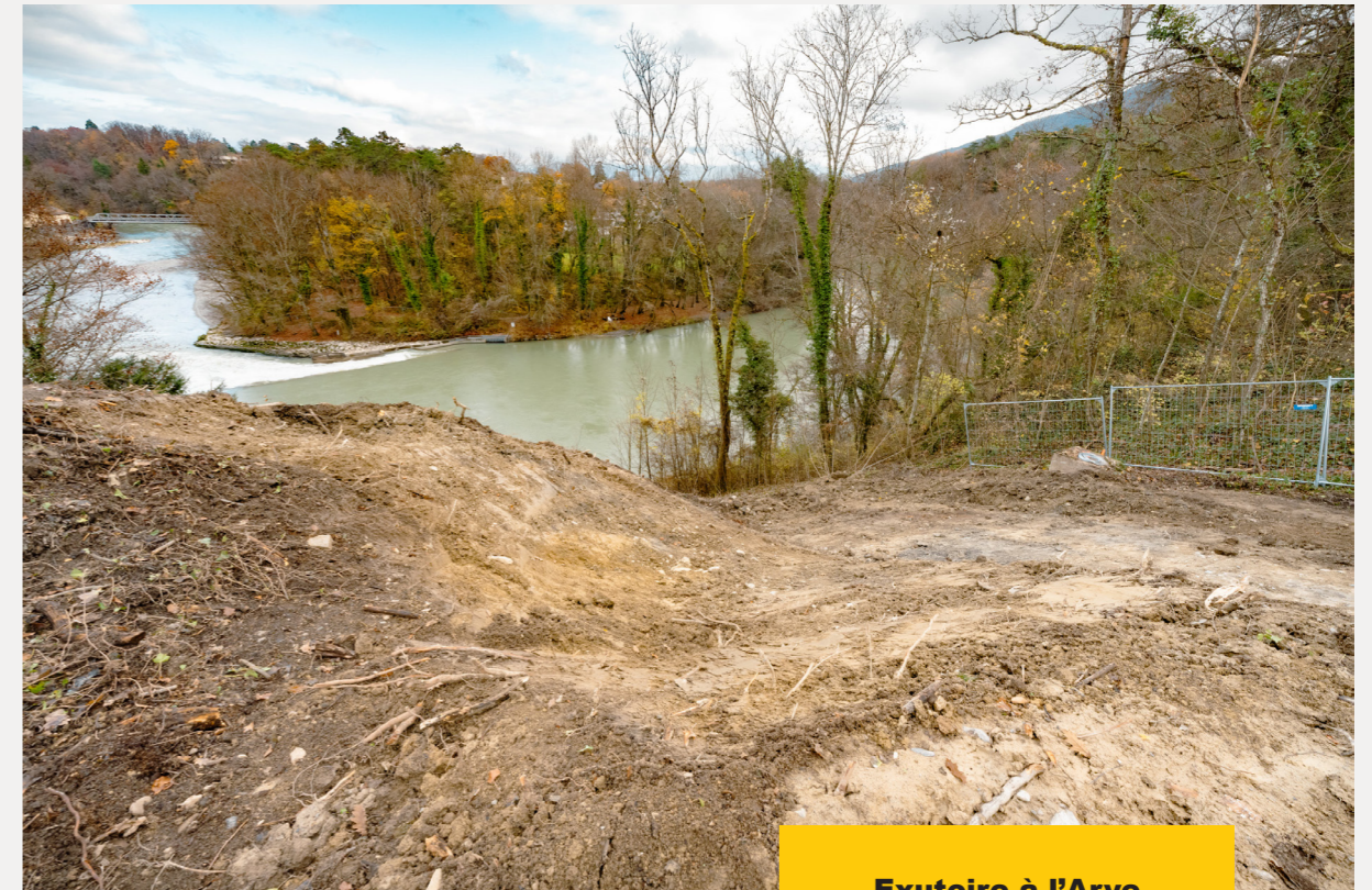
Exutoire à l'Arve
