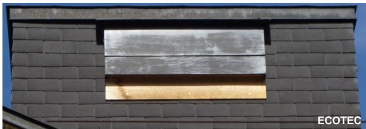
Nichoir « plat » multi compartiment installé sur le toit de l'arsenal cantonal, rue de l'Ecole de médecine, à Genève.
