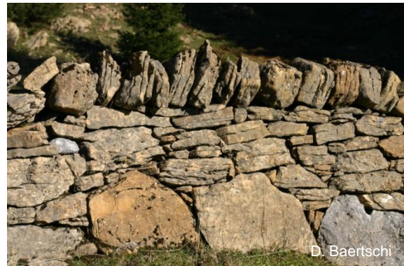
Détail de murs en pierres sèches
