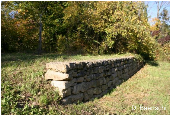
Mur de soutènement en pierres
