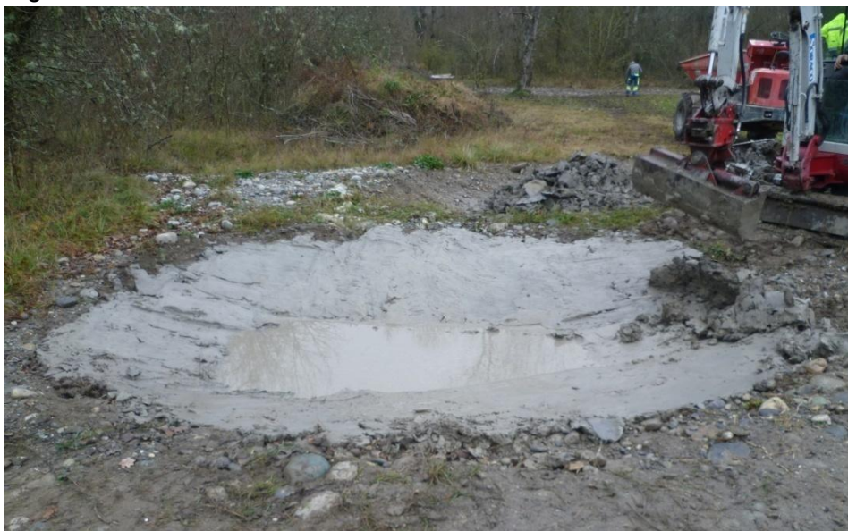
Mare sur sol perméable avec pose d'argile lissée au godet, Raclerets, 2011
